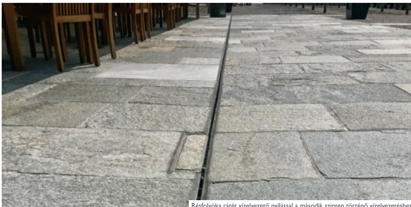
Résfolyóka rátét vízvezető nyílással a második szinten történő vízvezetéshez.
